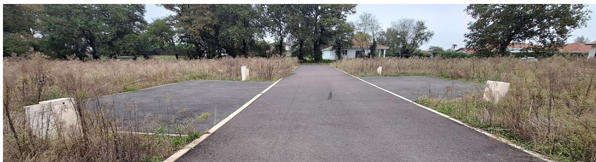
Zone 1AU au nord, viabilisée, en cours de commercialisation.
