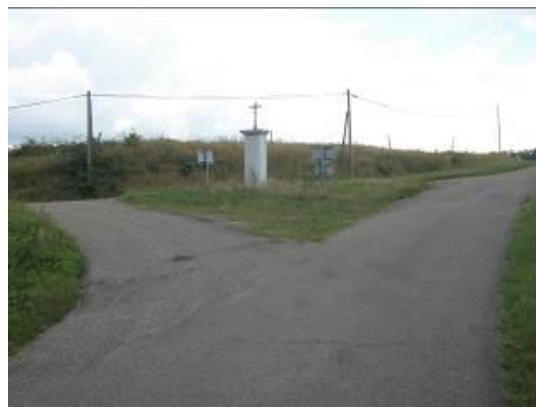
Revêtement tri-couche de l'Impasse du Bayle (à gauche) ainsi que de la Croix de la Barthe (à droite)
