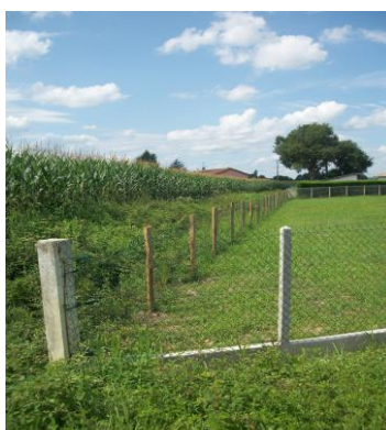
Nettoyage et clôture des abords de l'ancienne école.
